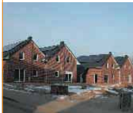
Wohnsiedlung mit Beglau-Wärmepumpen-Direktsystem mit Solarer Stromversorgung
