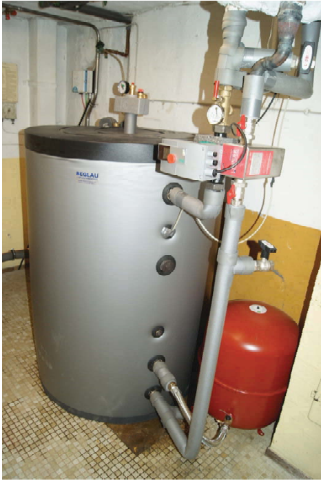
Wärmepumpenspeicher mit Direktkondensation
