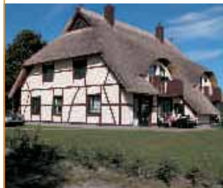
Ferienhaus mit Erdwärme-Direktverdampfung
